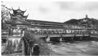
都江堰南桥,即当年丁宝桢修建的普济桥
